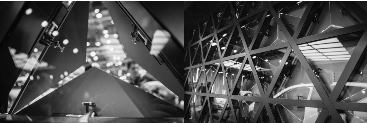
Mecanismo modular de apertura de Kinetic Wall y estructura soportante del muro respectivamente. Fuente: www.leva.io/projects/kinetic-wall
