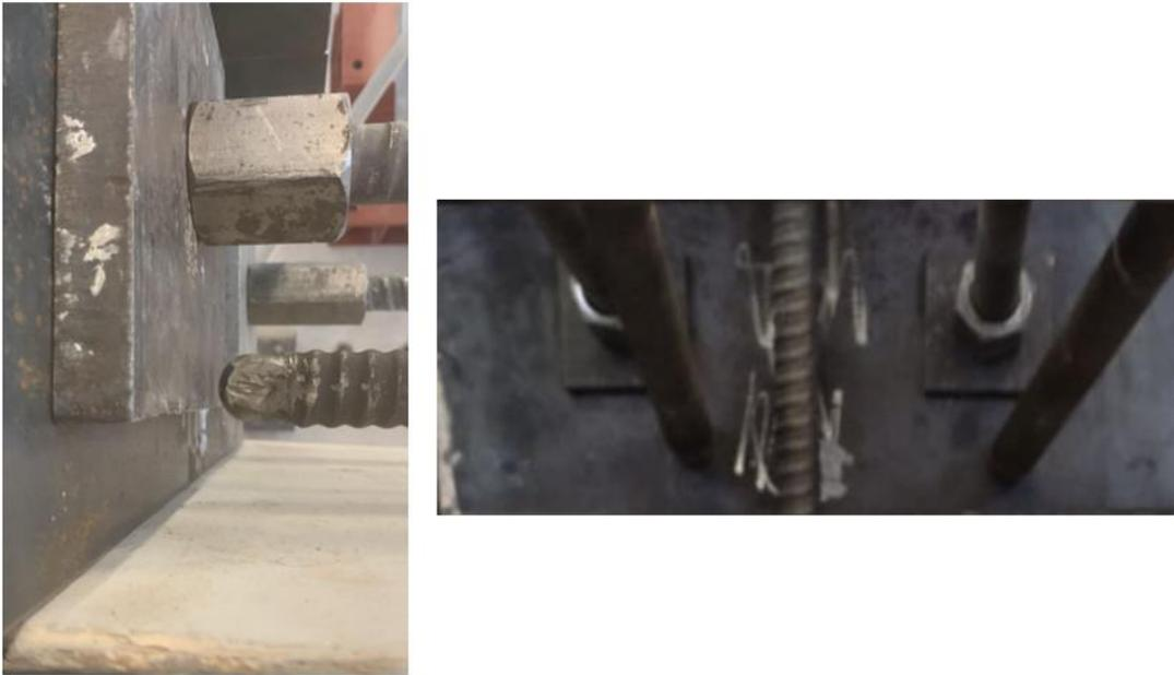
Figura 4.13: Placas de postensado en viga de transferencia, placa normal(izquierda) y placa modificada(derecha).
