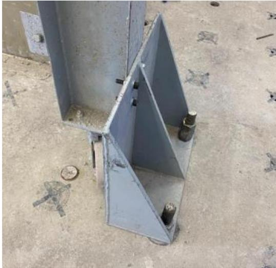
Figura 4.16: Cuñas de anclaje a losa del marco de acero.
