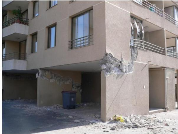
Figura 2.8: Daños típicos en muros de corte. [Figura 1-15]
