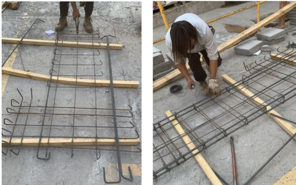
Figura 3.6: Construcción del armazón estructural.
