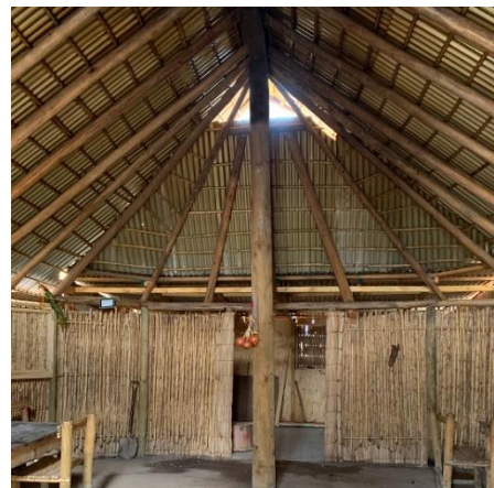
Imagen 13 Ruca Mapu Rayen, Padre Hurtado. Registro de detalles en rucas. Horcón. Elaboración propia. 2021.
