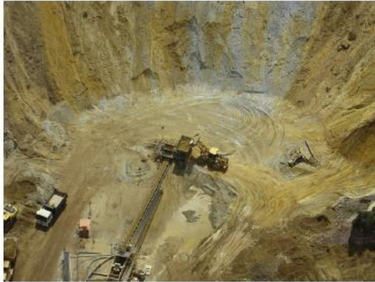
Figura 7: Remoción a través de método mecánico y estación de repulpeo (Wates & Götz, 2016).
