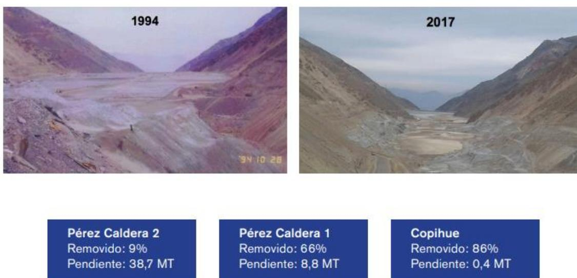
Figura 15: Antes y después del proceso de remoción de los depósitos de relaves PC2, PC1 y Copihue al año 2017 (Anglo American, 2019).
