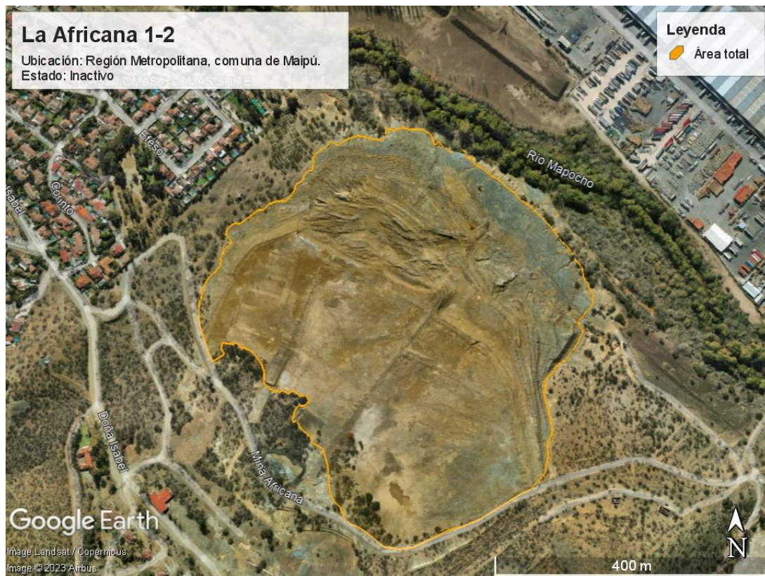
Figura 4-13: Depósito de relaves inactivo “La Africana 1-2”. Fuente: Google Earth.
