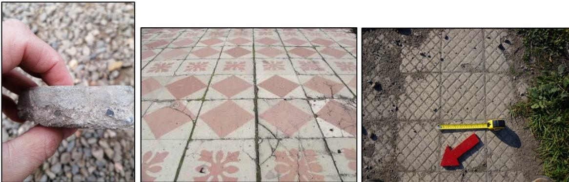
**Figura 7, a la izquierda. Detalle del perfil de baldosa decorada, en donde se observan las dos capas que componen la pieza. Figura 8, al centro. Patrón de distribución del mosaico hidráulico en la Estación de Melipilla, con dos filas de rombos por una de flores. Figura 9, a la derecha. Baldosa tipo “chocolate” en la Estación. Fuente: Elaboración propia. Mayo 2021.**
