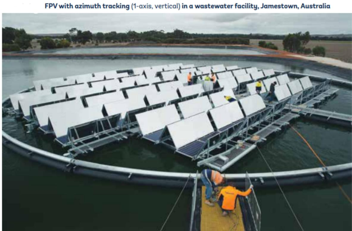
Figura 3.4: Arreglo de paneles solares flotantes con seguimiento vertical en Australia[11]
