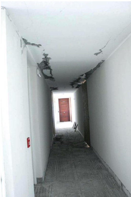
Fig. 3 Daño en losas de acople de pasillos y marcos de puertas (John Wiley & Sons, 2010)
