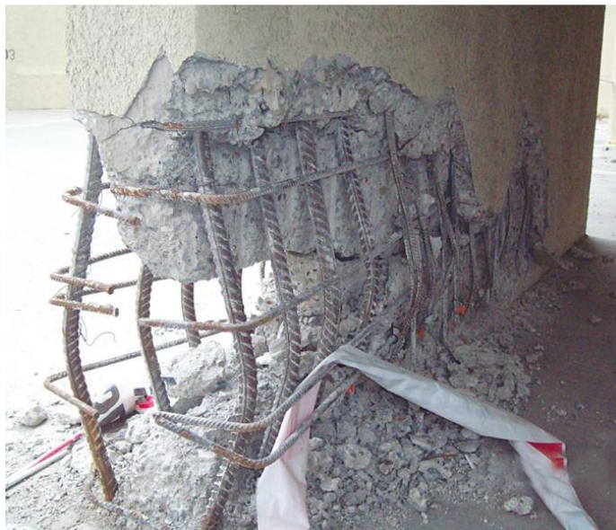
Fig. 1 Daño observado en muro de hormigón armado por flexo – compresión (Rojas & Massone, 2012)
