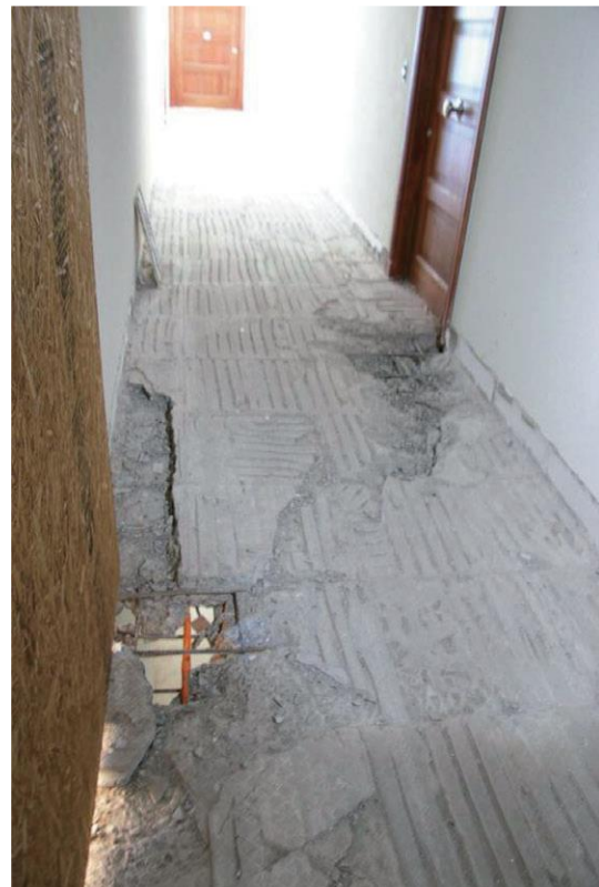
Fig. 3 Daño en losas de acople de pasillos y marcos de puertas (John Wiley & Sons, 2010)
