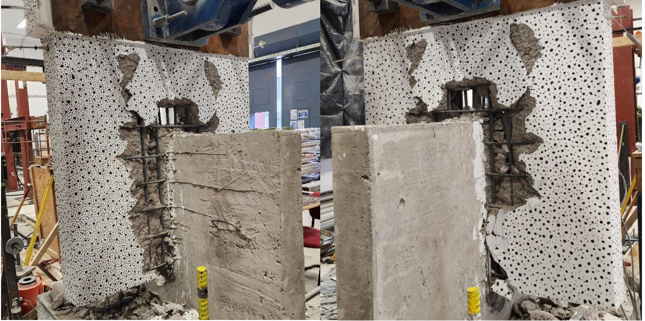
Fig. 29 Daño presentado en la Losa Sin Trabas
