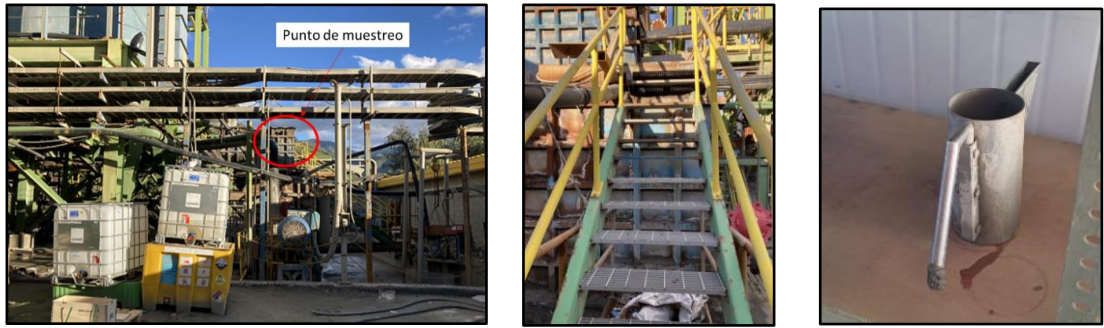
Figura 10.16. Lugar donde se toma la muestra. Cortador de muestra metálico.
