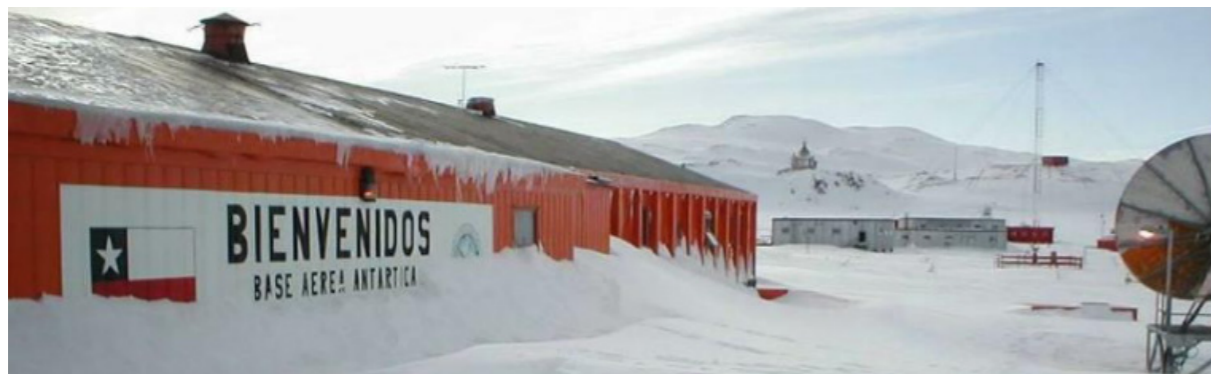
^ Sistema Tohá implementado en la Base Chilena Antártica. Fuente: Tratamiento de Basura y Sistema Tohá para el Tratamiento de Aguas servidas Antártica (BAAPEFM).
