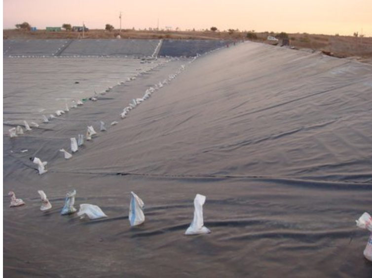
Figura 3.5: Utilización de geomembrana como método de impermeabilización para Friosa en Chillán. Fuente: All Power Energy, s.f.
