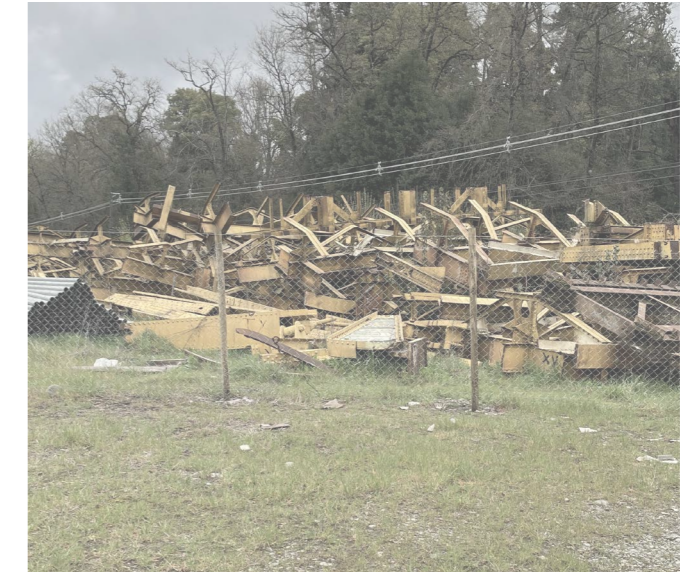
VESTIGIOS DE PUENTE TOLTEN
