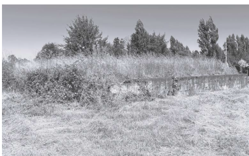
Cimiento Bodega Radal
