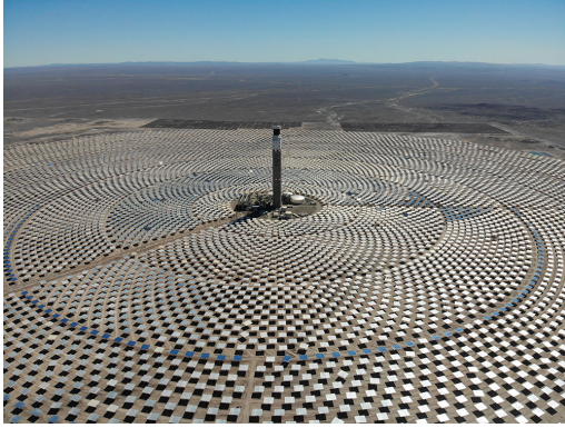
Figura 5.1: Planta de receptor central del complejo Cerro Dominador . Extraído de [42].
