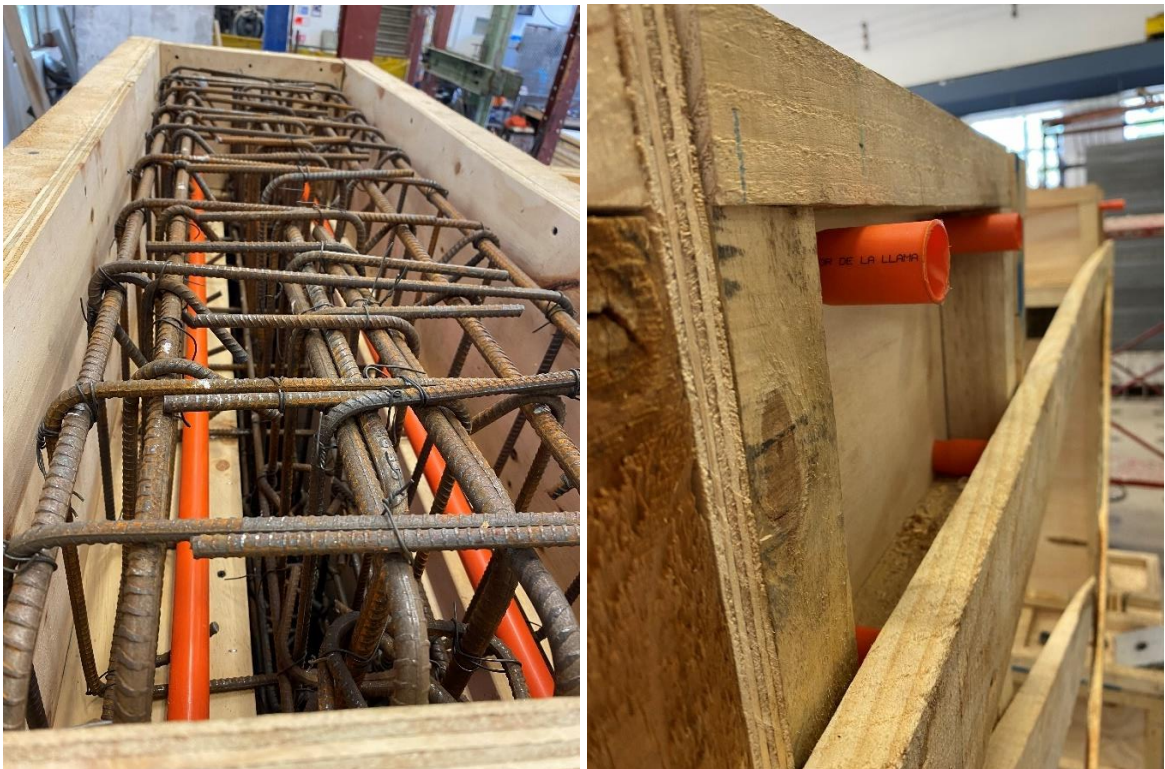
Figura 4.7 : Colocación de tubos PVC a través de los moldajes y enfierradura.
