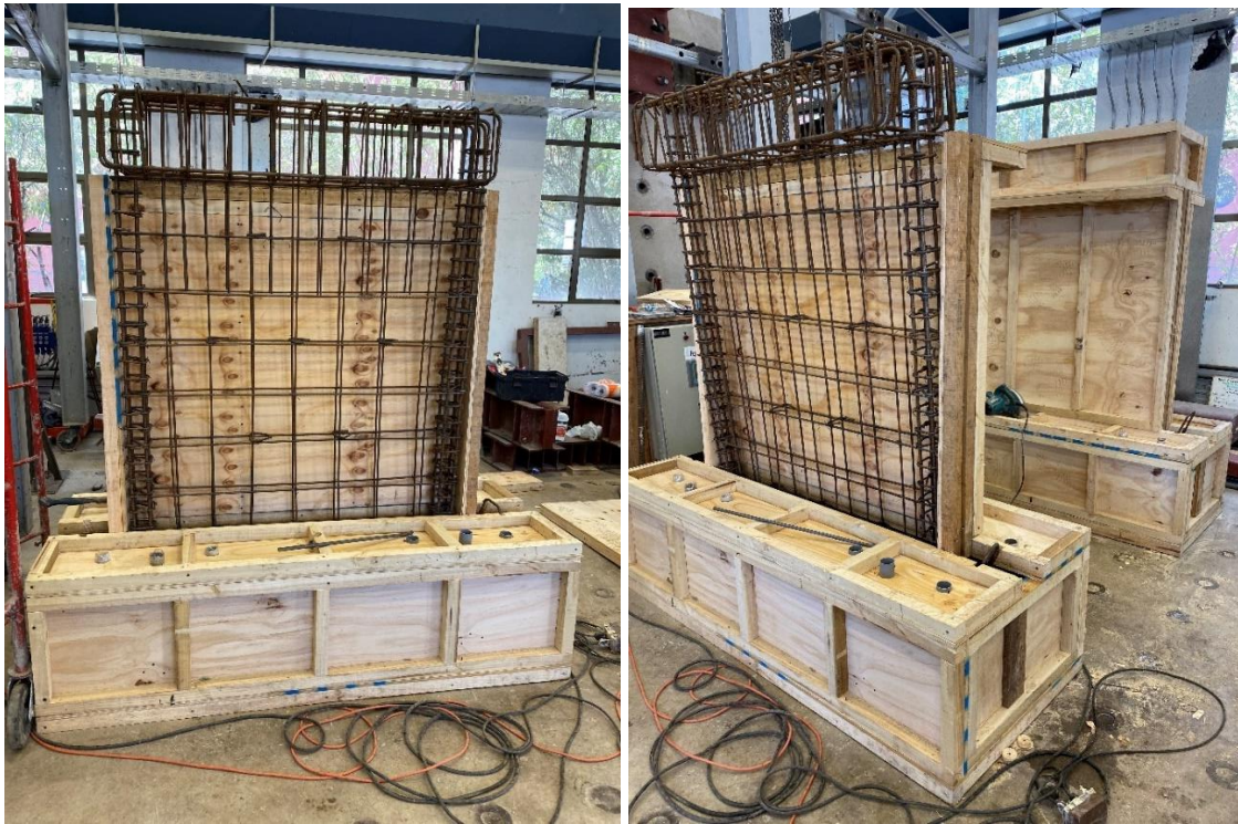
Figura 4.6 : Colocación de moldajes en muros.
