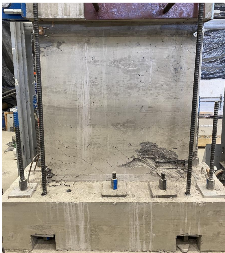
Figura 5.11 : Vista final desde el lado norte del muro alternativo.
