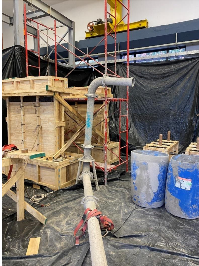
Figura 4.8 : Zona previa a hormigonar.
