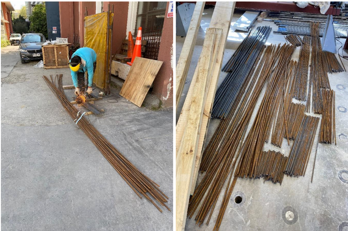
Figura 4.2 : Corte de barras de acero.
