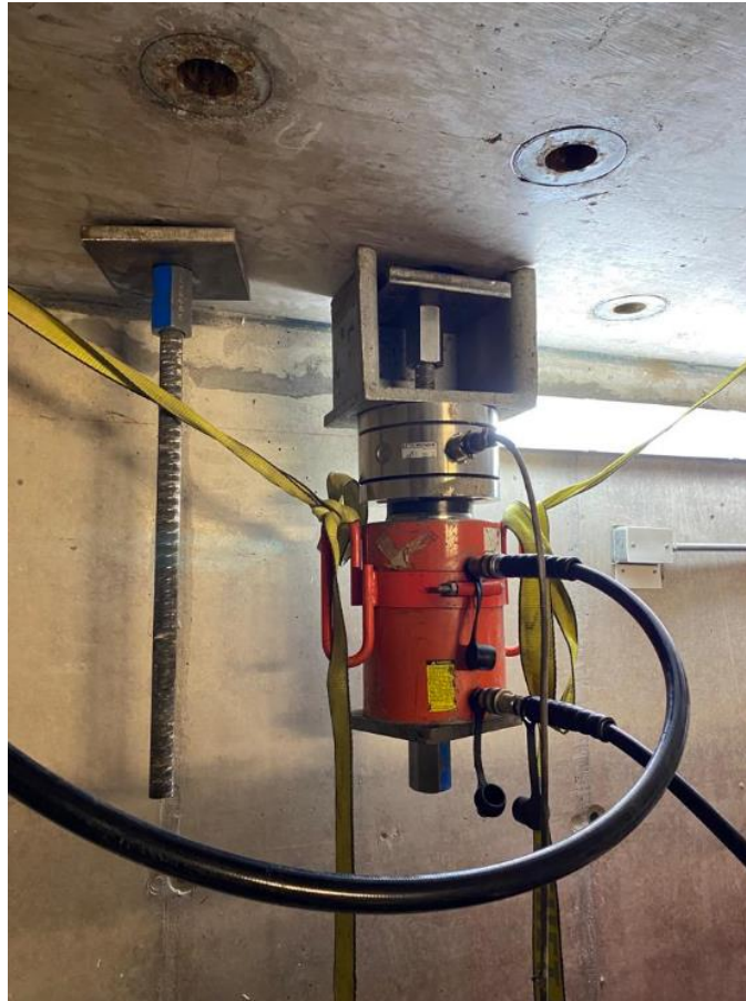
Figura 4.21 : Postensado de barras internas.
