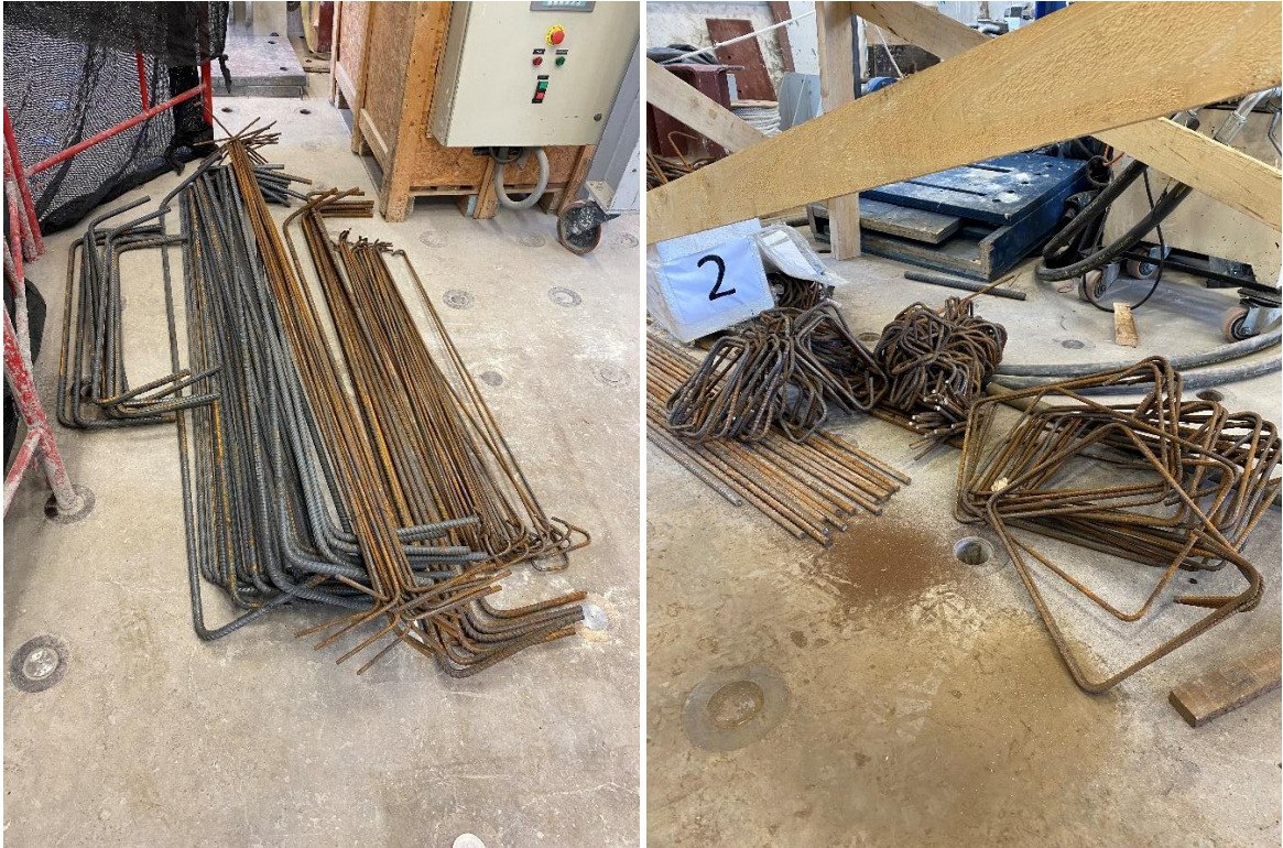
Figura 4.3 : Doblado de barras longitudinales y estribos.
