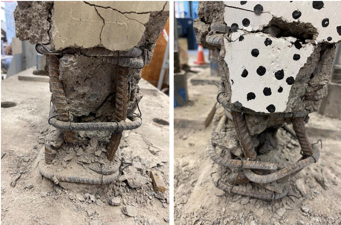
Figura 5.9 : Vista final de los bordes inferiores oeste y este respectivamente.
