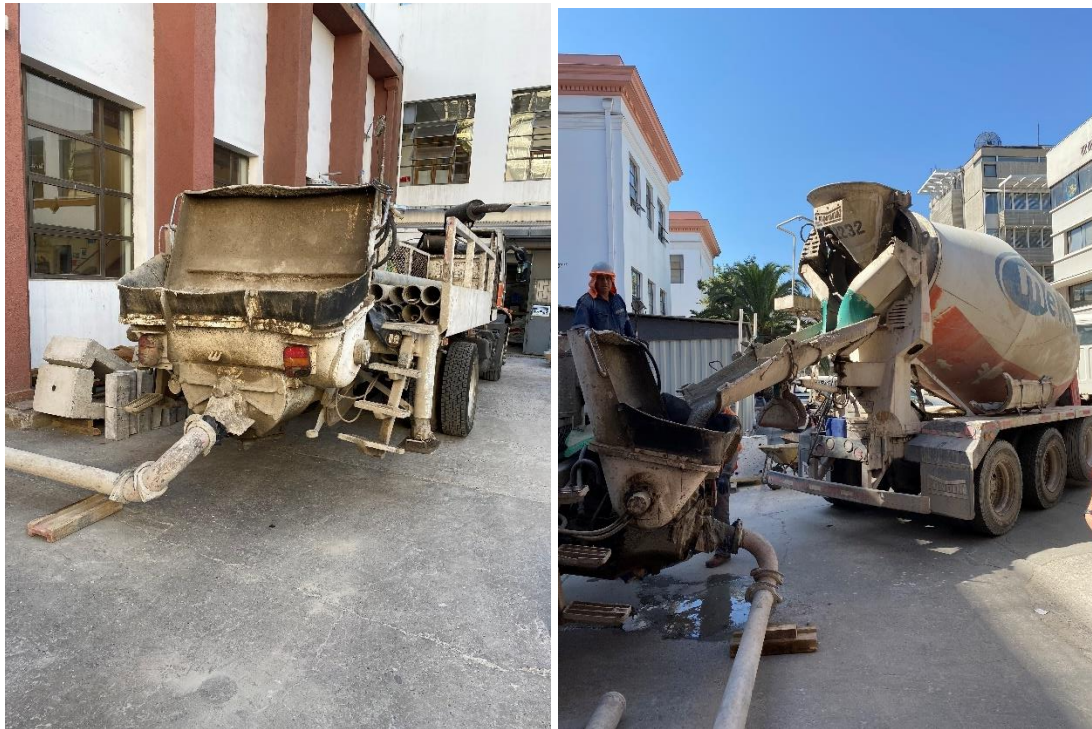
Figura 4.9 : Camiones utilizados en la faena de hormigonado.
