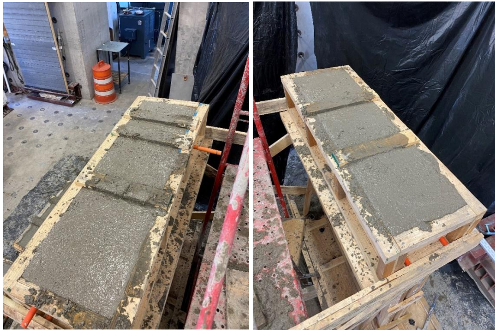
Figura 4.13 : Vista desde arriba de los muros hormigonados.
