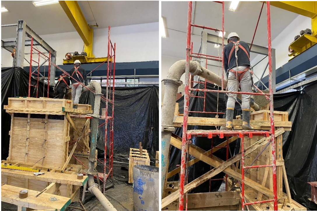
Figura 4.10 : Hormigonado de muros.
