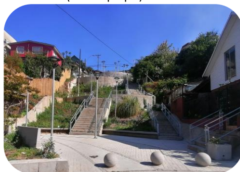
Vía de evacuación como escalera ubicada en pasaje El Mirador con Balmaceda (Fuente propia).
