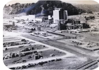
Construcción Planta Celco, etapa final, c.1970 (Cortez y Valero, 2011:107)
