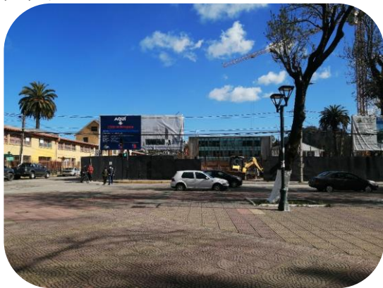
Construcción del Teatro Municipal, ubicado en esquina Montt con Oñederra (Fuente propia).
