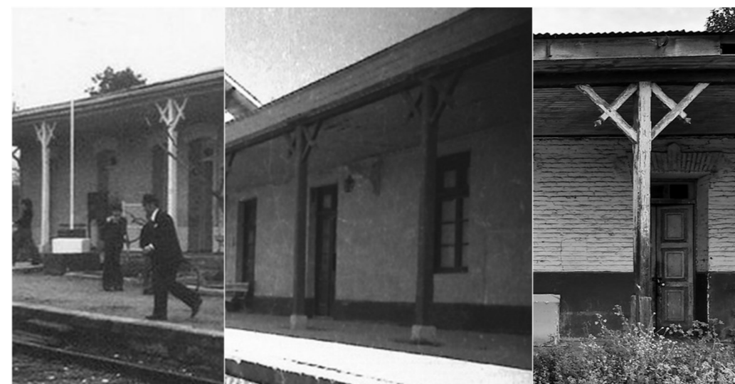
Fig. 13: Pilares de Madera con escuadra en cruz en cubiertas de los andenes del ramal. Elaboración Propia en base a fotos disponibles en la web.
