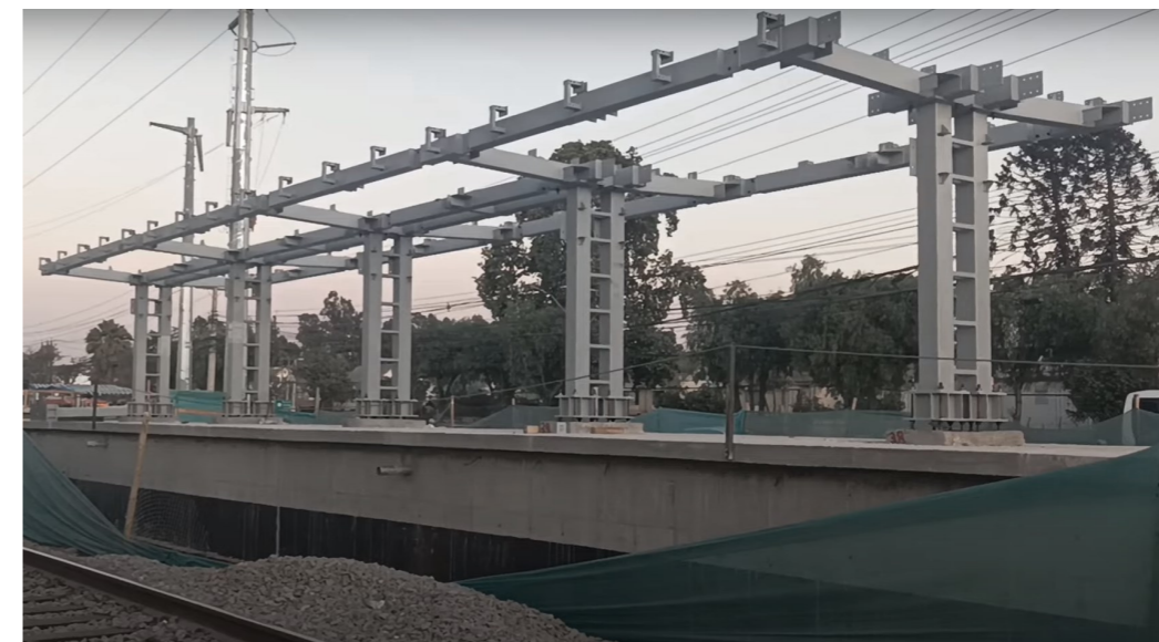
Fig. 24: Avances Estación Tres Poniente. Google Street View.
