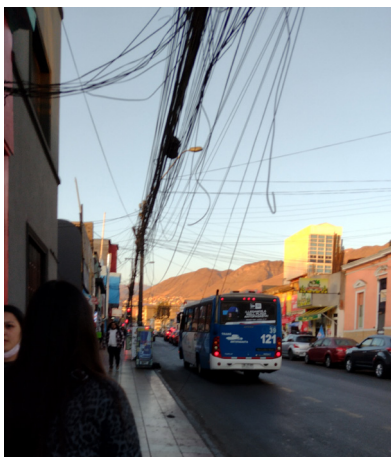
Imagen 38. Estado Actual Cableado Fuente: Elaboración Propia
