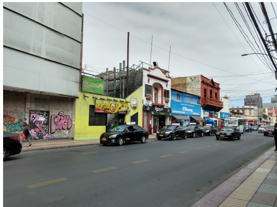
Imagen 53. Estado Actual Fachada Fuente: Elaboración Propia
