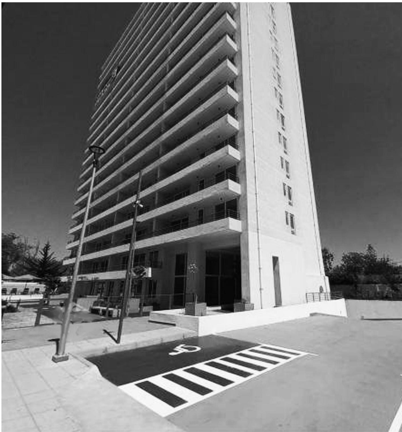
Imagen 11 : Edificio residencial ,vista desde Avenida Pajaritos
