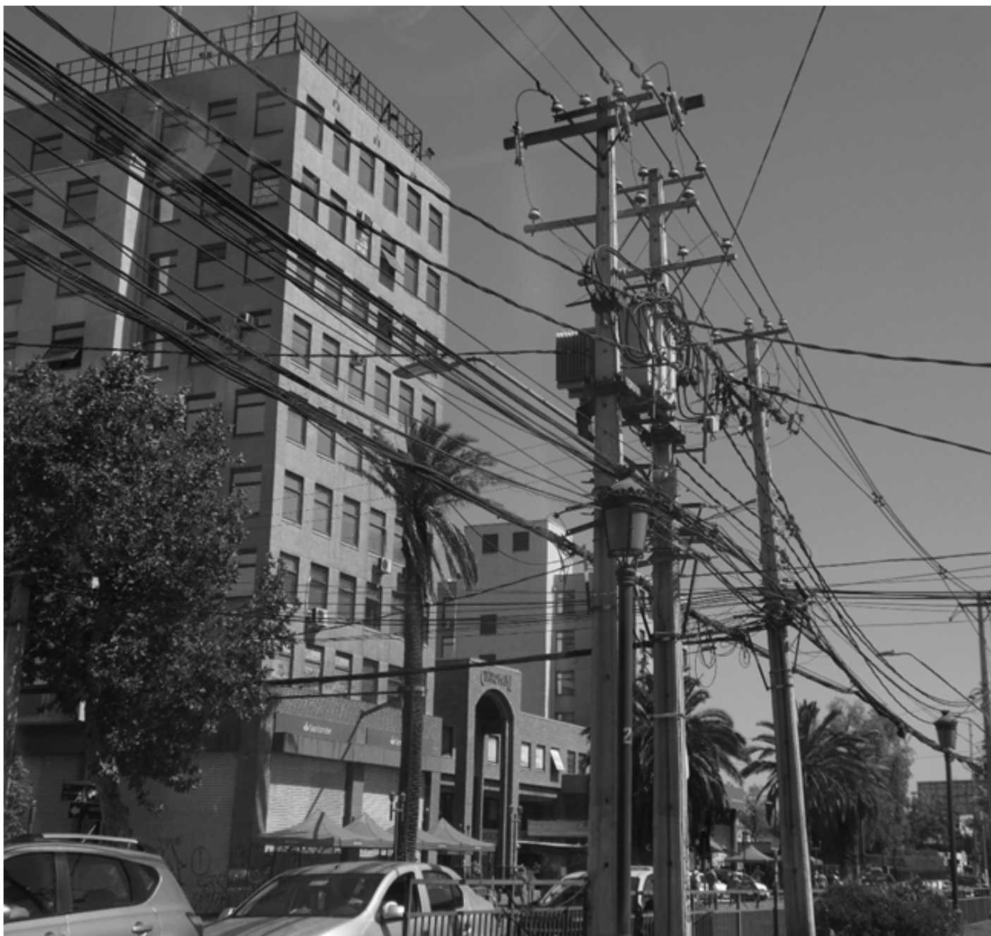
Imagen 4 : Edificio residencial, vista desde Avenida Pajaritos
