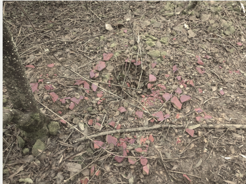
Registro personal (2023). Tejas a nivel de suelo.
