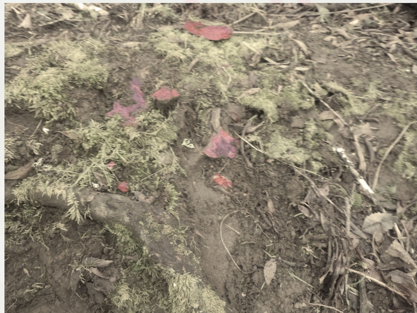
Registro personal (2023). Tejas a nivel de suelo.
