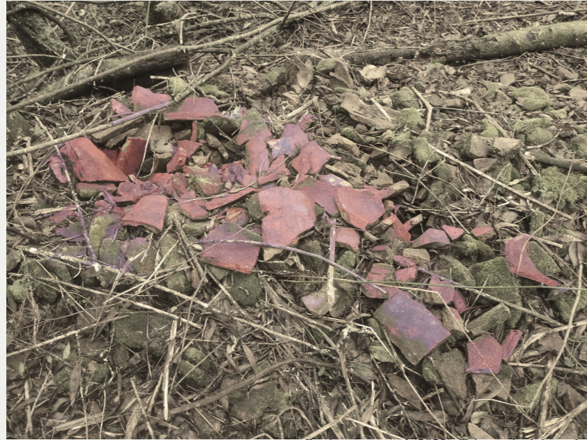
Registro personal (2023). Tejas a nivel de suelo.
