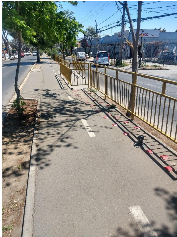
1.7.15 Fotografía 8: Interrupción en ciclovia Av. Laguna Sur con Juan Guzmán.
