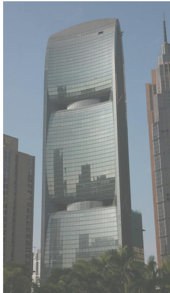
Figura 05: Diseño aerodinámico de captación de ráfagas de viento. Torre Pearl River. China , CTBUH Selects the 4 Best Tall Buildings for 2013 | Gallery | Archinect
