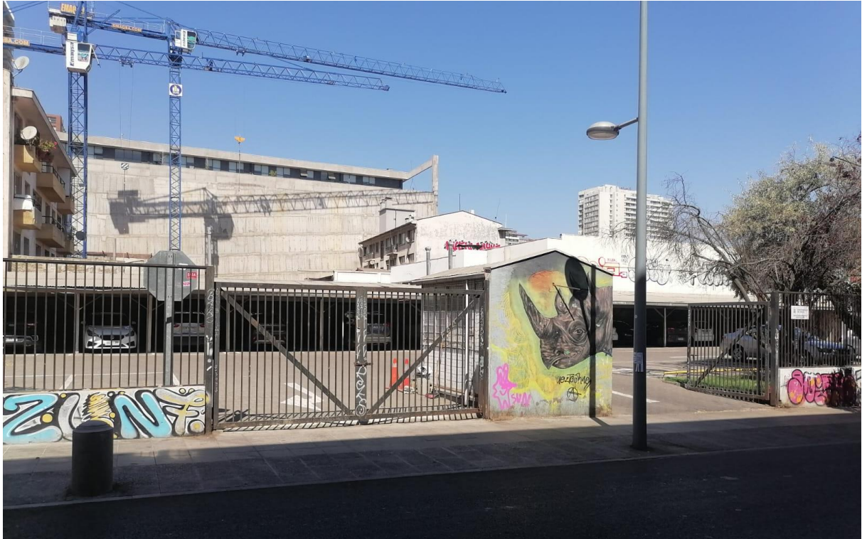
Imagen N°79: Cara Norte del terreno. Fuente: Registro personal de elaboración propia.
