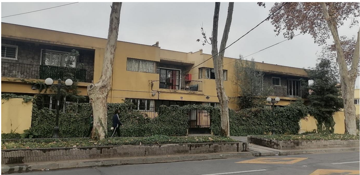
Imagen N°4: Residencias universitarias actuales de la U. de Chile. Fuente: Registro personal de elaboración propia.
