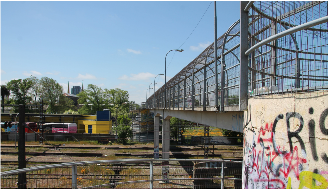
Figura 21: Elaboración propia. Oct, 2023. Pasarela Ultraestación. Fotografía.
