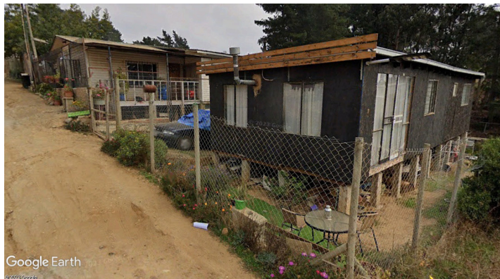
Registro de una construcción típica en Laguna Verde Fuente: Google Earth
