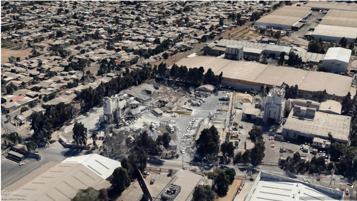
Planta de Hormigón Polpaico en Renca
