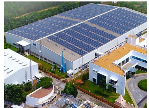
Paneles Fotovoltaicos instalados en depósito industrial
