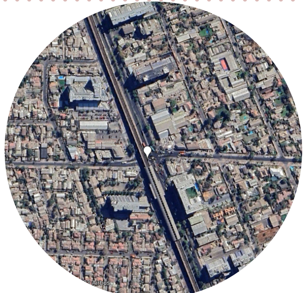
Imagen 31. Del año 2023, metro Rojas Magallanes, La Florida, perteneciente a Línea 4 de metro de Santiago extraída de google earth. (2023)
