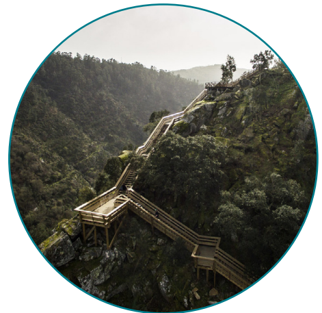
Figura 47: Vista escaleras de Pasarelas Paiva Fuente: Garrido, 2015.
