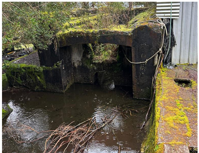
Figura 29: Canales de las fundaciones Fuente: Elaboración Propia, 2023.
