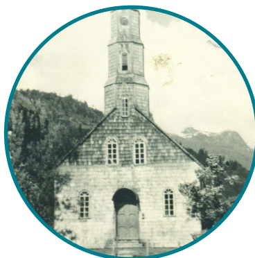
Figura 15: Iglesia de Cochamó Fuente: Villarroel, 1978.
