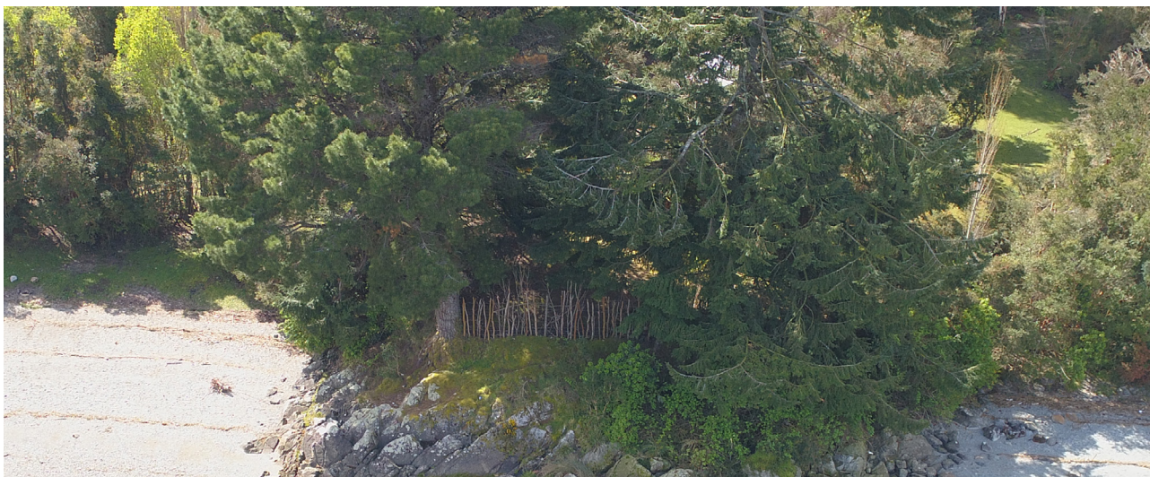
Figura 30: Vista aérea área de fundaciones cercada Fuente: El Último Sur, 2023.
