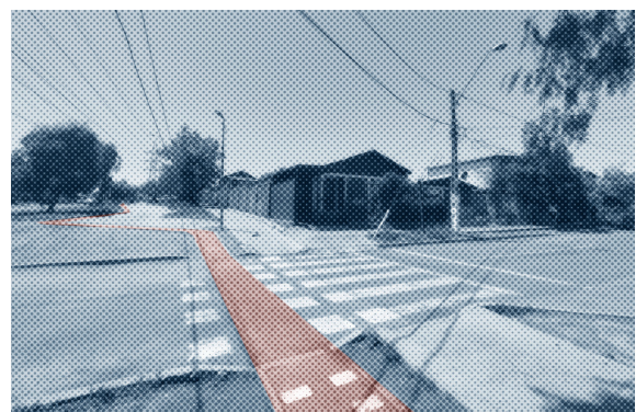
Figura 10. Avenida las Torres, mala condición del espacio público. Elaboración propia
