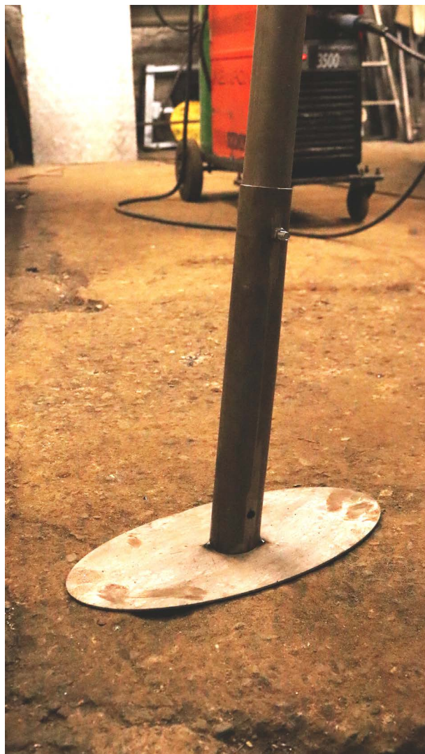
Imagen 37 : Detalle de apoyo de verticales estructura 1:1
