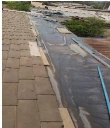
Fotografía 9. Daños en la cubierta del CESFAM Manuel Rodríguez. Tomado de (Gobierno de Chile, 2015a).
