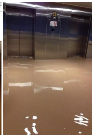
Fotografía 4. Nivel de inundación y pérdida de utilidad de ascensores en el Hospital de Copiapó tras aluvión de 2015. Tomado de 24Horas, s.f. b.
