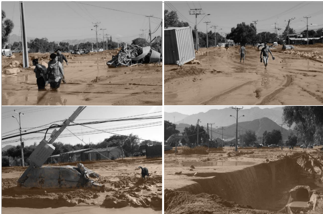
Fotografía 5. Daños y altura de flujos de detritos y de barro en las calles de la ciudad de Copiapó por el aluvión de 2015. Elaboración propia en base a Espinoza, S., 2015.
