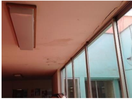
Fotografía 10. Daños en el cielo del Cesfam Santa Elvira. Tomado de (Gobierno de Chile, 2015a).
