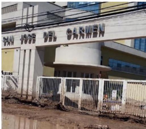
Fotografía 2. Daños y altura de los flujos de detritos y de barro, impiden el acceso al Hospital de Copiapó tras el aluvión de 2015. Tomado de Departamento de Gestión de Riesgos en Emergencias y Desastres, 2016.
