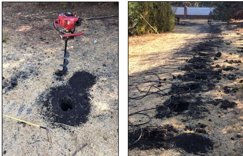
FIGURA 14. PERFIL DE PRUEBA DE ELECTRODOS. TAZAS REALIZADAS CON AHOYADORA.
