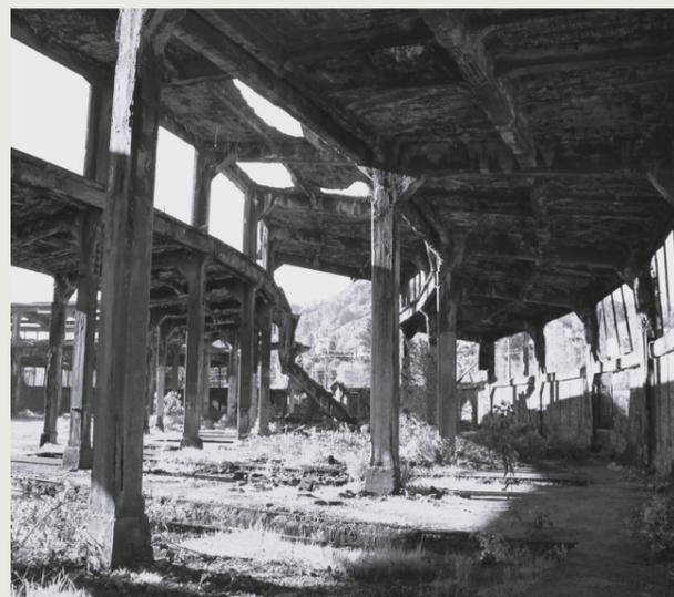
La casa de máquinas fue el primer edificio terminado, está construido de hormigón armado y vigas de acero, además cuenta con un muro perimetral de albañilería ladrillo.
