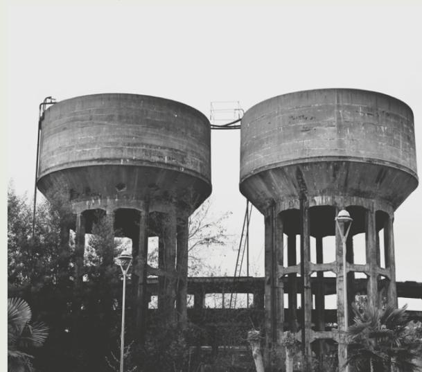
Las torres de agua son 2 estanques de hormigón armado con una capacidad de 500 metros<sup>3</sup>, esta cuenta con 45m<sup>2</sup> y tiene una altura de 17 metros. Una de las copas se llenaba con agua del río Laja y se utilizaba para la ducha de los trabajadores, mientras que la otra contenía agua tratada para utilizarla en las locomotoras y el consumo.
