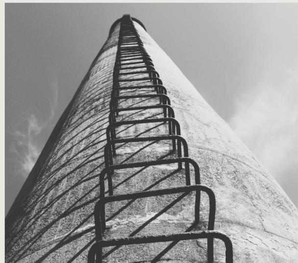
La chimenea está construida por hormigón armado y se encuentra entre la maestranza y la casa de máquinas, cuenta con 9m<sup>2</sup> y tiene una altura de 30 metros. Esta tenía la función de conducir y expulsar humo de combustión producto de la reparación realizada en la maestranza.
