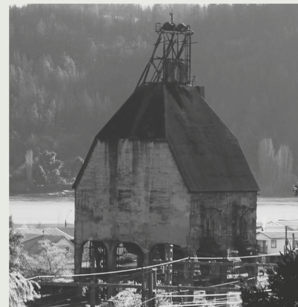
La carbonera del Complejo Ferroviario de San Rosendo es una estructura de 200m<sup>2</sup> hecha de hormigón armado que cuenta con 40 metros altura y una base rectangular de 12 pilares de 0.8x0.8m.
