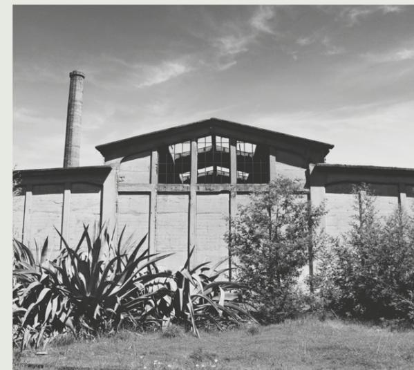
La maestranza es un edificio de 900m<sup>2</sup>, de doble altura y planta libre. Esta se compone de un volumen de hormigón armado con sistema estructural aporricado en donde existe una repetición de 7 marcos rígidos que se encuentran cada 6.6m. La parte más alta alcanza los 10 metros mientras que la más baja es de 7. Esta estructura cuenta con una zona de reparaciones de partes y piezas de locomotoras, y zona de servicios para trabajadores, donde se encuentra la caldera, baños y casilleros.
