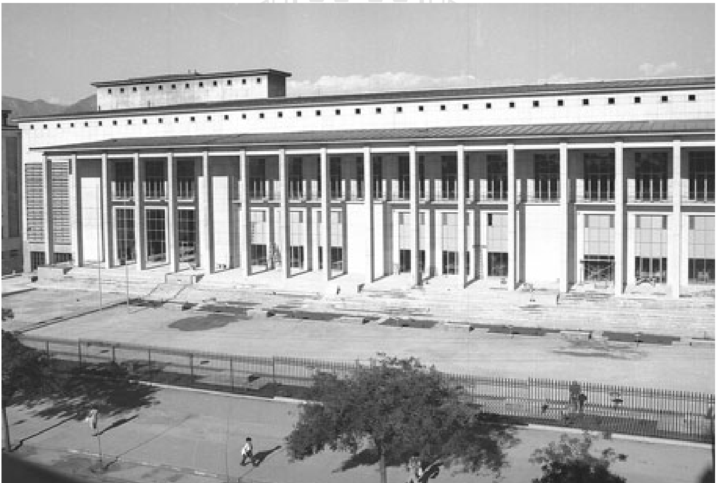
Imagen 15. Nueva facultad de Medicina de la UCH, 1967. Fuente: Colegio de Arquitectos Chile
