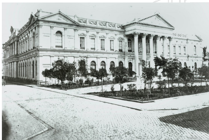
Imagen 10. Edificio del Congreso, construcción 1876, Santiago. Fuente: Biblioteca del Congreso Nacional
