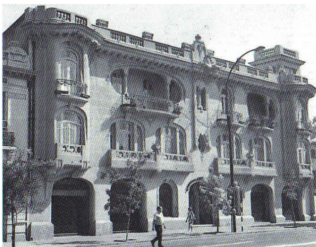
Imagen 18. Colegio de Arquitectos de Chile, s/a. Fuente: Sede Nacional Colegio de Arquitectos de Chile
