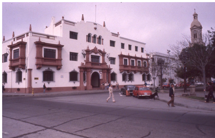
Edificio consistorial de la Serena (1938) Fuente: https://www.enterrreno.com/moments/municipalidad-de-la-serena-1980-8429
