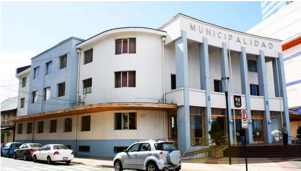
Edificio municipal de Puerto Montt. Fuente: https://diariopuertovaras.cl/buses-gratuitos-puerto-montt/
