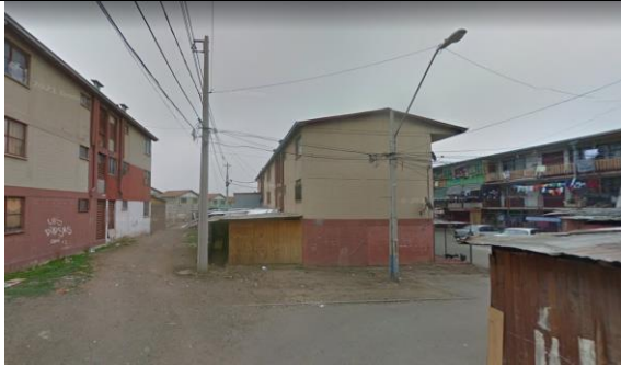
Calle Valle Central 1191, Puente Alto.
