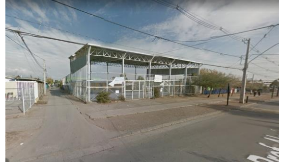
Sede Vecinal Villa Carol Urzúa - Prof. Alcaíno 1034, Puente Alto.
