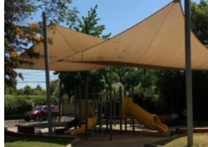
Fig.37: Plaza cercana con mobiliario estandar. Fuente: Registro propio.
