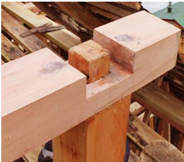
Fig.4: Registro de una Unión de caja y espiga con Media madera. Fuente: Uniones Carpinteras - Tradición, técnica y cultura de un Oficio (Verdugo, 2020).
