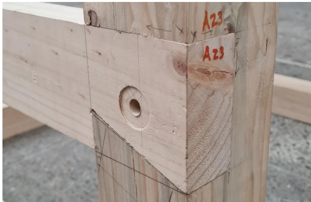
Fig.22: Daño por perno en Unión Media cola de milano, B23. Fuente: Elaboración propia.
