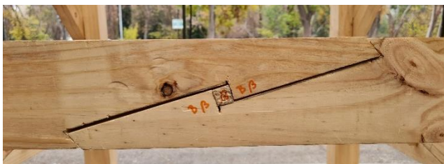
Fig.19: Empalme rayo de Júpiter. Elaboración propia
