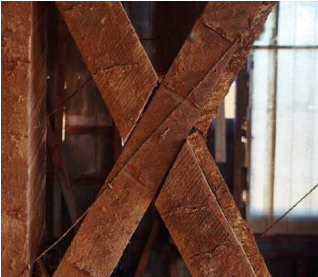
Fig.5: Registro de una unión de media madera en cruz oblicua. Fuente: Libro, Uniones carpinteras de Valparaíso, (Gonzalez & Maino, 2019).
