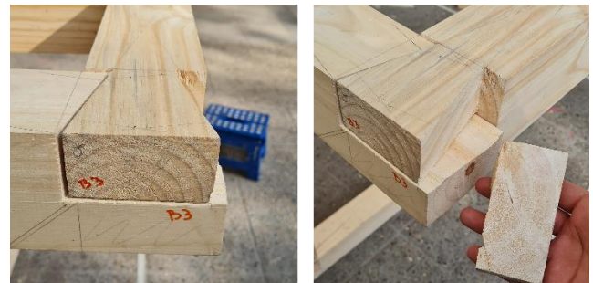
Fig.14: Daño estructural, Unión B3. Elaboración propia
