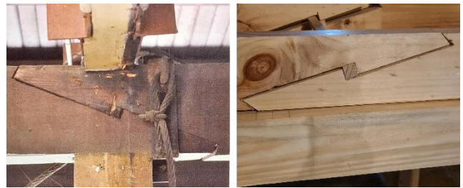
Fig.7: Comparación unión carpintera de Valparaíso con unión de elaboración propia. Fuentes: "Uniones carpinteras de Valparaíso" (González & Maino, 2019); Elaboración propia.
