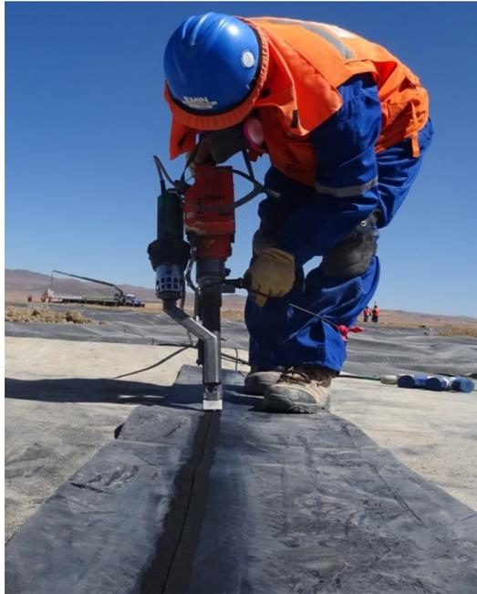
Figura 4.19: Máquina extrusora.
