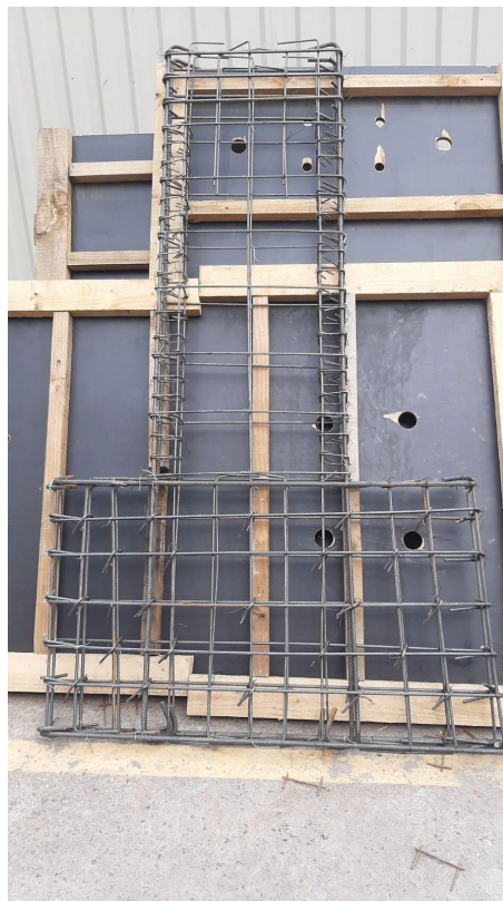
Figura 3.9: Armadura Muro 2
