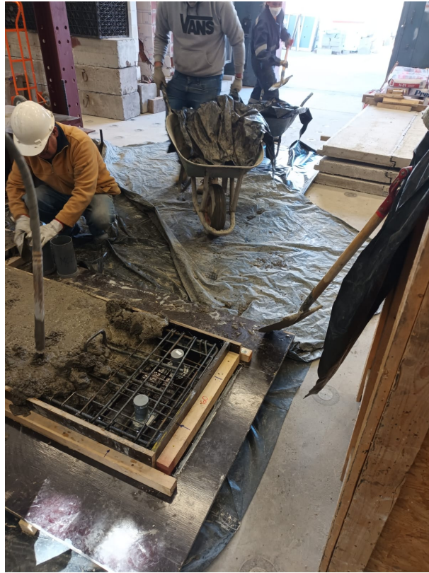
Figura 3.12: Hormigonado
