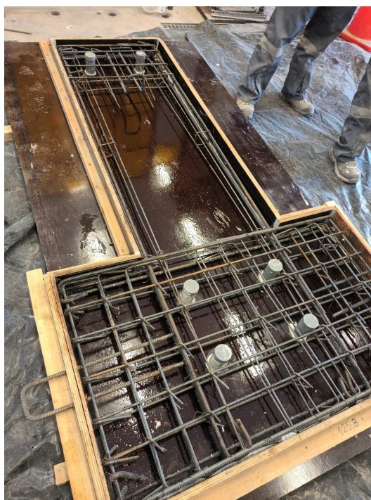
Figura 3.10: Armadura Muro 3
