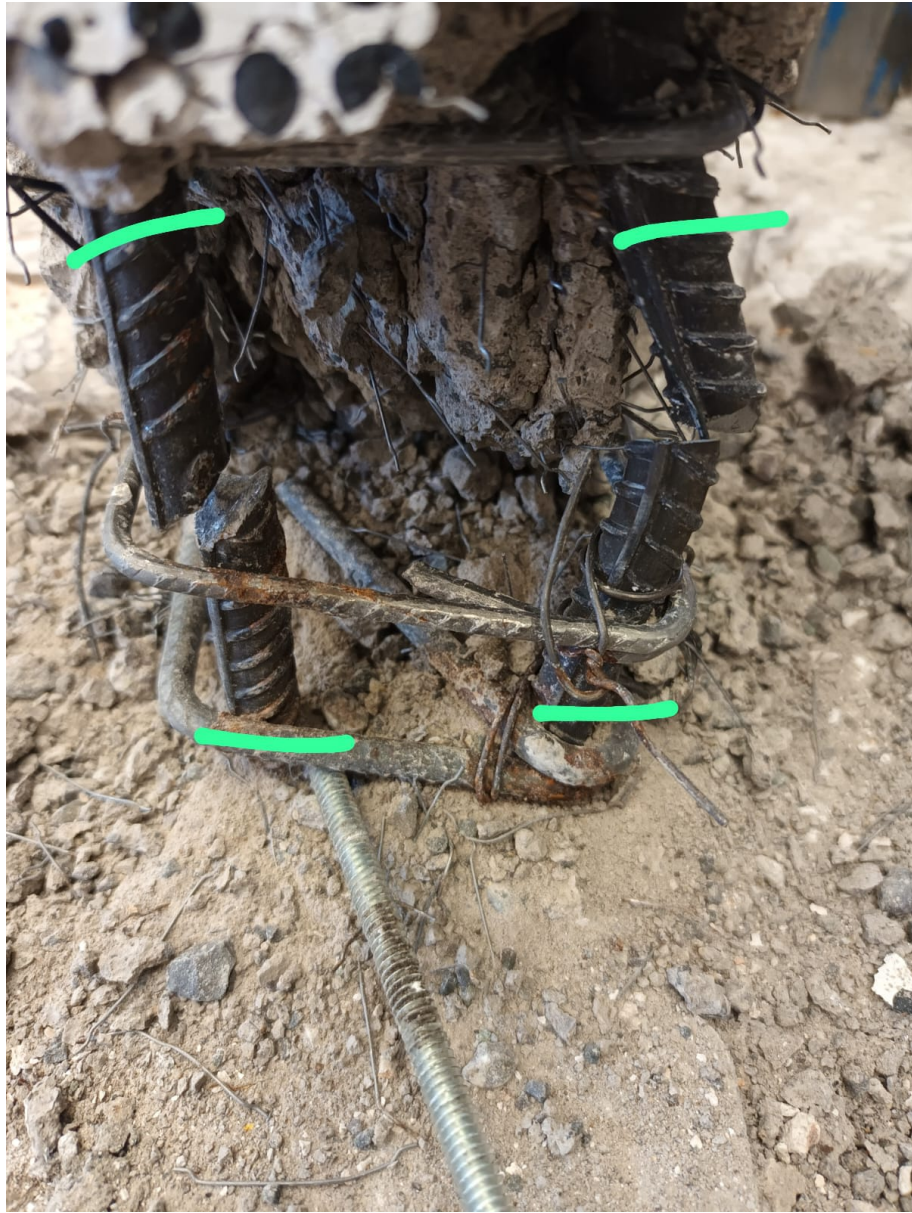
Figura 4.27: Cortes de barra después de retirar hormigón
