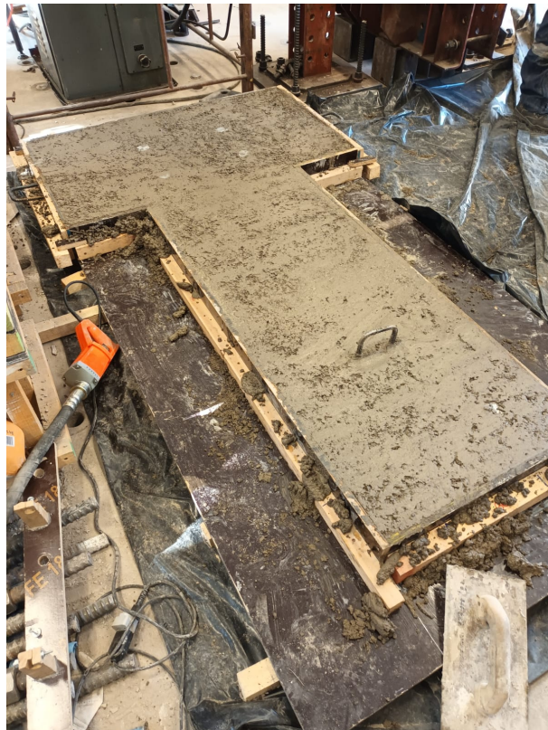
Figura 3.13: Forma final del hormigonado
