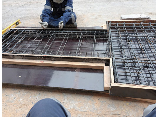
Figura 3.8: Armadura Muro 1
