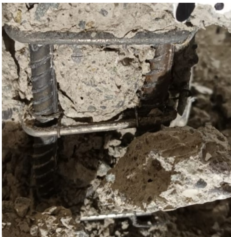
Figura 4.10: Corte estribo lado cordillera
