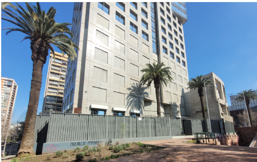
[Fig 70] Fachada actual de la Mutual de Seguridad, tomada el 25/08. (2023). Fuente: Elaboración propia
