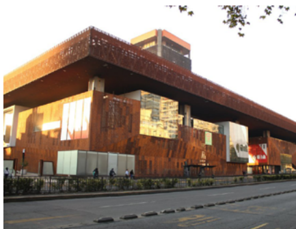
[Fig 60] Edificio tras la 1ra etapa de remodelación. (s.f). Fuente: GAM
