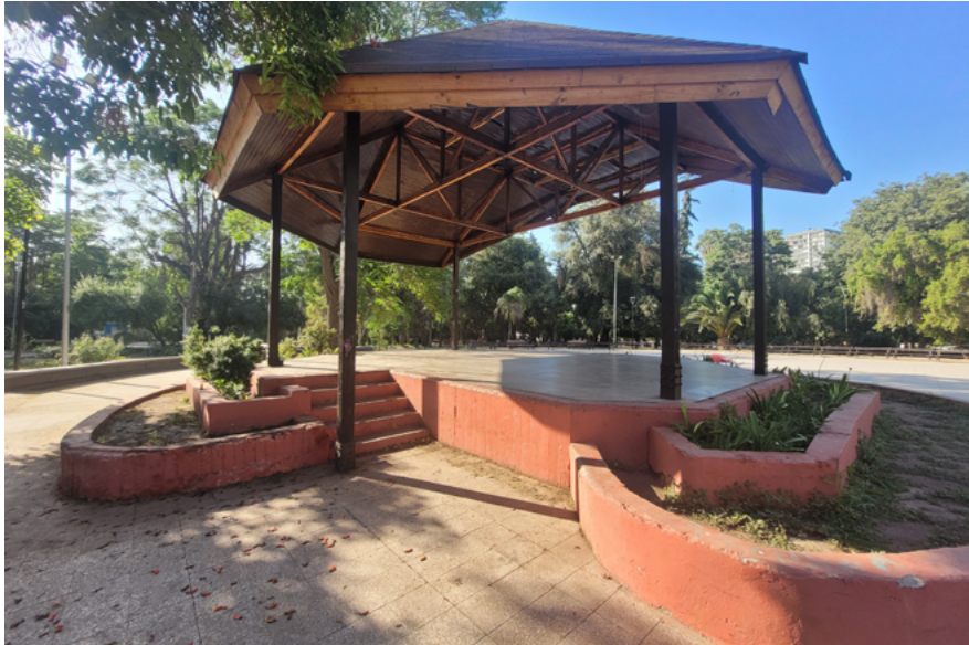
[Fig 97] Espacio designado para instalar la intervención de la fase II, tomada el 12/12. (2023). Fuente: Elaboración propia.
