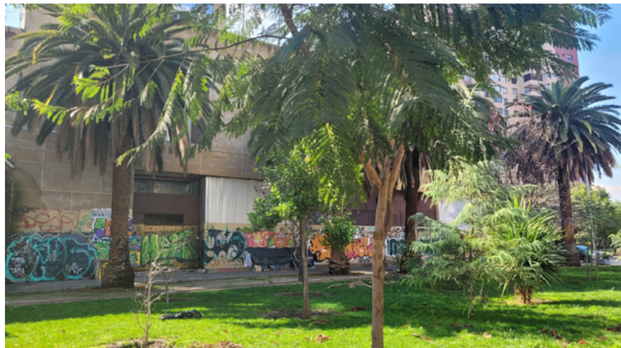
[Fig 71] Ventanales del costado de la galería tapados con planchas de madera, tomada el 25/08. (2023). Fuente: Elaboración propia.
