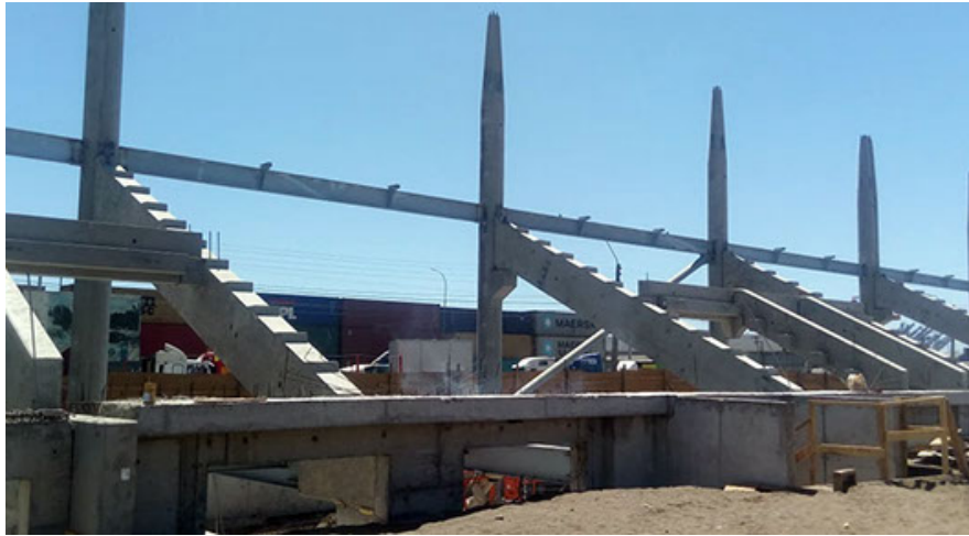
Figura 3.1: Graderías prefabricadas en proceso de montaje. Fuente: Página web Preansa
