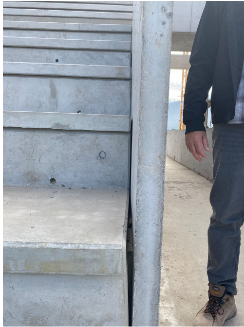
Figura 3.68: Desangulación de gradería prefabricada puesta en obra. Fuente: Imagen propia, visita a planta de producción.
