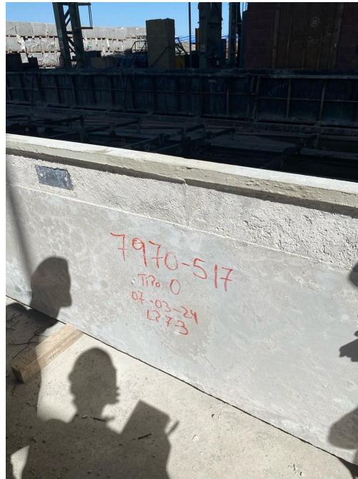
Figura 3.66: Identificación grada prefabricada en planta de producción. Fuente: Imagen propia, visita a planta de producción.
