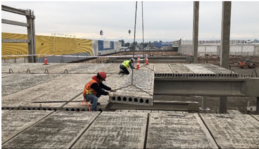
Figura 3.4: Instalación de losas alveolares prefabricadas. Fuente: Página web Preansa
