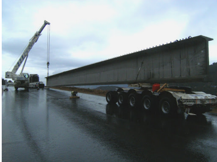
Figura 3.17: Transporte de viga prefabricada de hormigón. Fuente: Página web Indaico.
