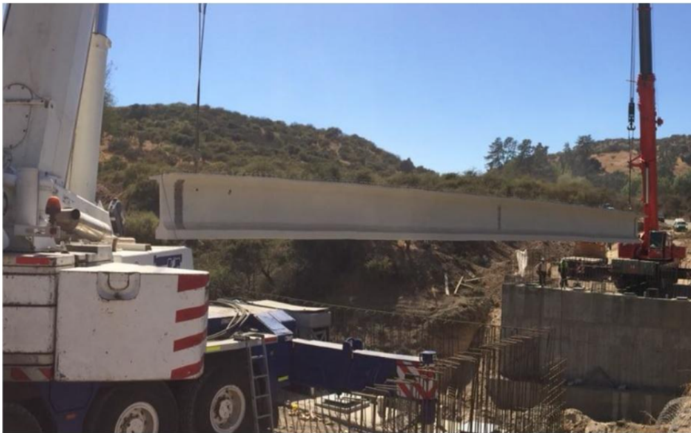
Figura 3.19: Utilización de grúas telescópicas para el montaje de piezas prefabricadas. Fuente: Página web Tensacon.
