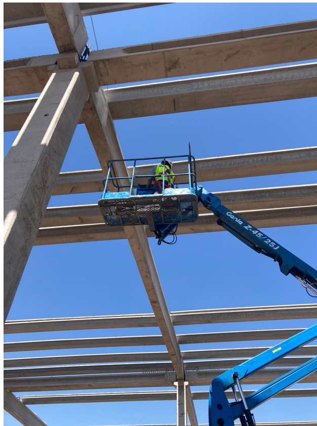
Figura 3.20: Ejemplo de uniones provisorias. Fuente: Imagen propia, visita a terreno galpón Fruna, empresa a cargo Preansa.
