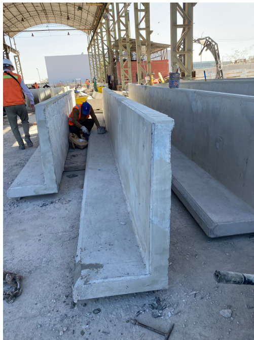
Figura 3.65: Grada prefabricada en planta de producción. Fuente: Imagen propia, visita a planta de producción.
