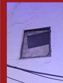
Figura 59: Detalle retiro de vitral original
