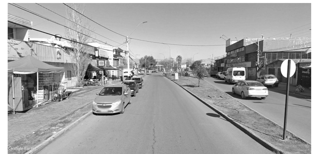
Figura 28: Deterioro Avenida Neptuno.
