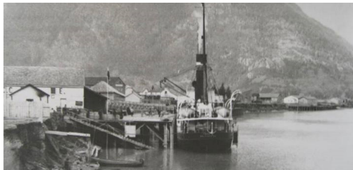
Fig. 24. Muelle Puerto Aysén. Fuente: Unidad de Patrimonio Histórico de Aysén
