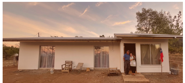
Figura 99. Vista fachada principal Casa Quiroz. (Obtenida en visita a terreno, 2024).
