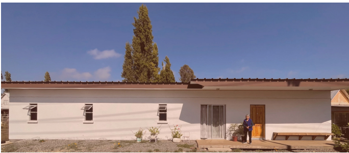
Figura 75. Vista fachada principal Casa Ramírez. (Obtenida en visita a terreno, 2024).
