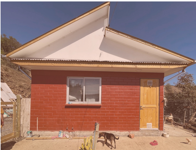
Figura 68. Fachada área cocina y zona intermedia pavimentada. (Elaboración propia en visita a terreno).
