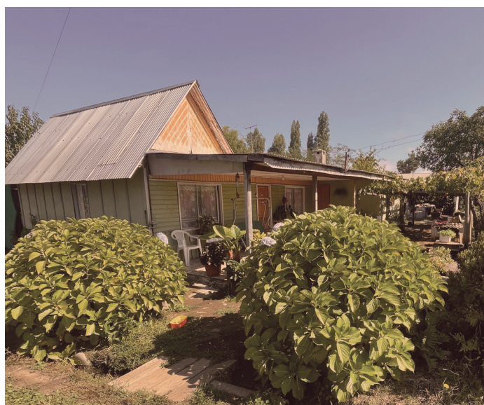
Figura 73. Vista vivienda antigua de Ramírez. (Obtenida en visita a terreno, 2024).
