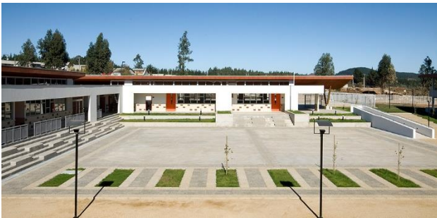
Figura 35: Patio Interior. Plataforma Arquitectura.
