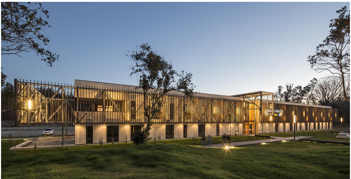
Figura 39: Vista Exterior. Plataforma Arquitectura.
