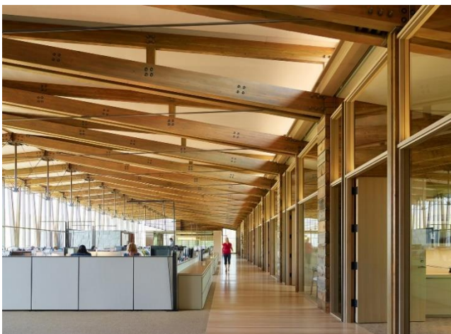
Figura 41: Vista Interior. Gooood.
