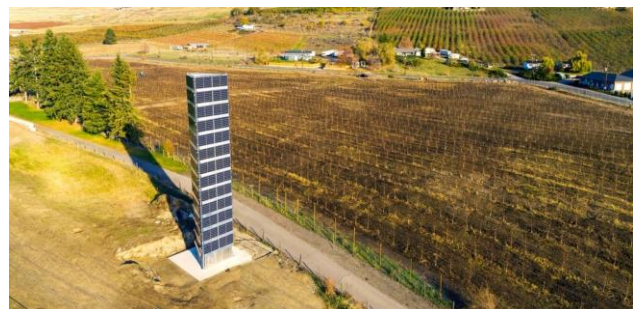
Figura 55: Torre Fotovoltaica en Canadá. Three Sixty Solar.
