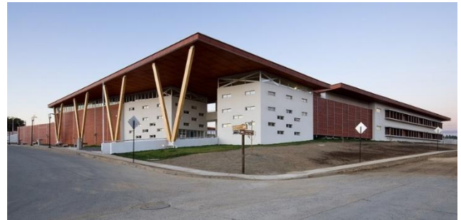
Figura 36: Vista Exterior. Plataforma Arquitectura.
