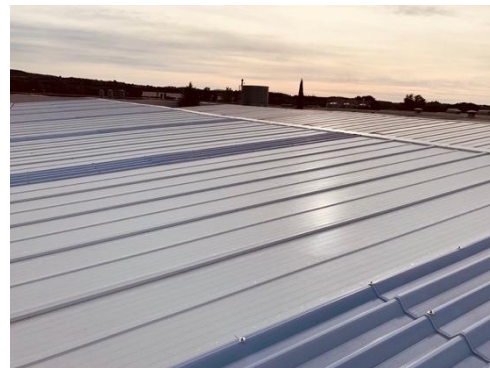
Fig.10; Cubierta sandwich. Fuente; https://sumavesa.com
