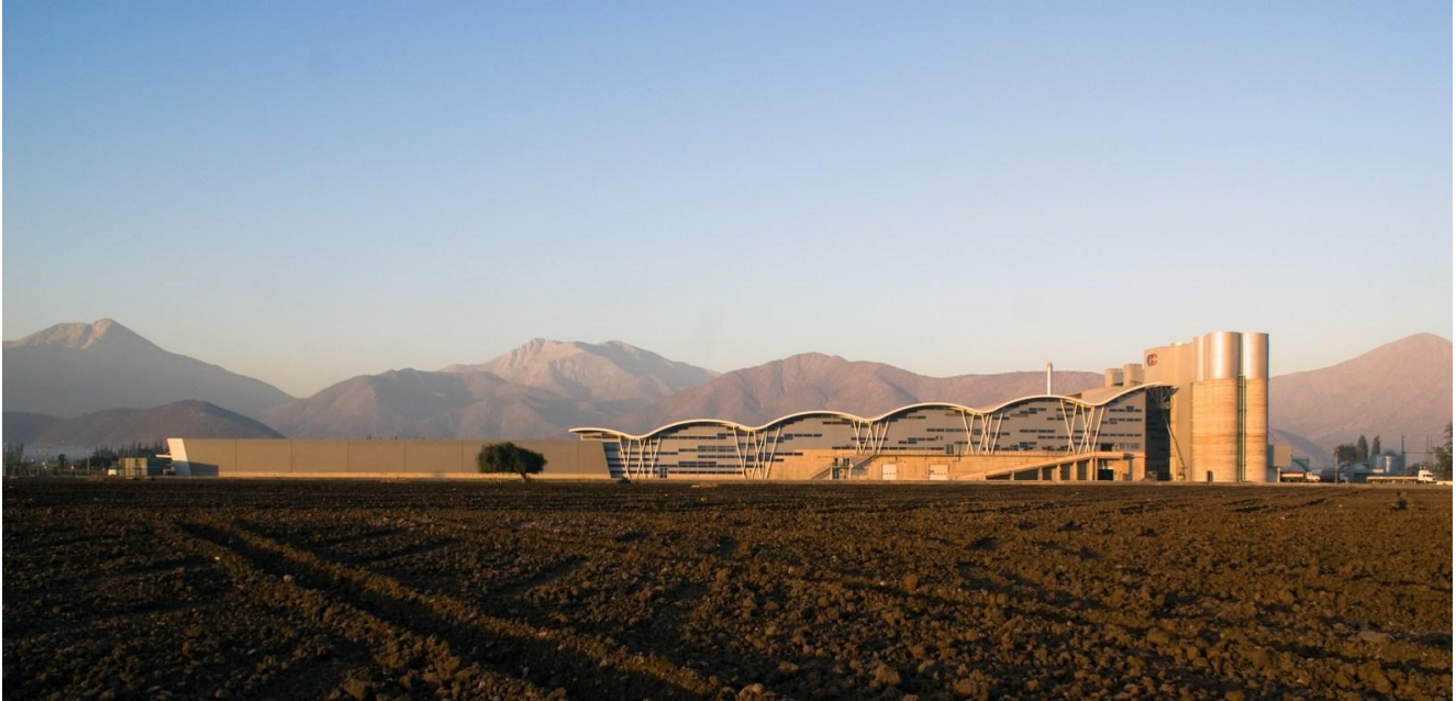
Fig. 22; Fachada sur Cristal Chile Fuente; https://plataformaarquitectura.com
