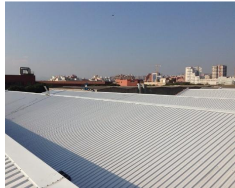
Fig.9; Cubierta simple. Fuente; https://sumavesa.com
