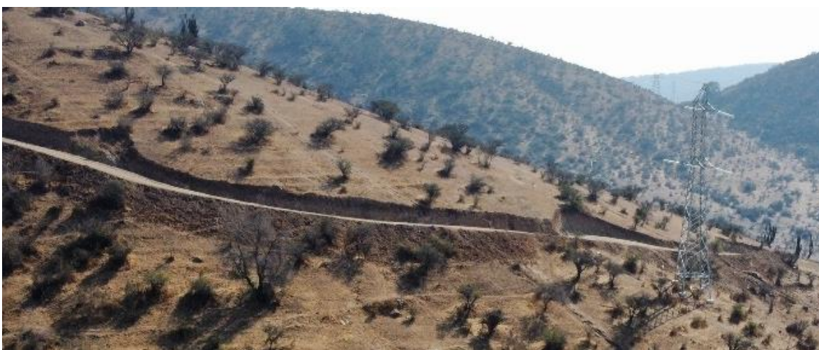
Figura 32. Talud en ladera de exposición norte.
