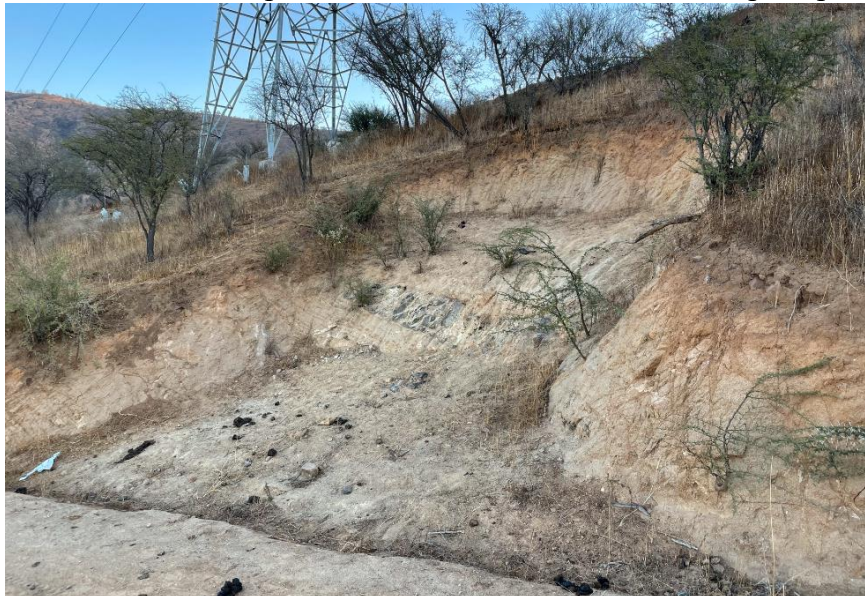
Figura 31. Retroceso de escarpe con afloramiento rocoso. Suelo de poca profundidad.
